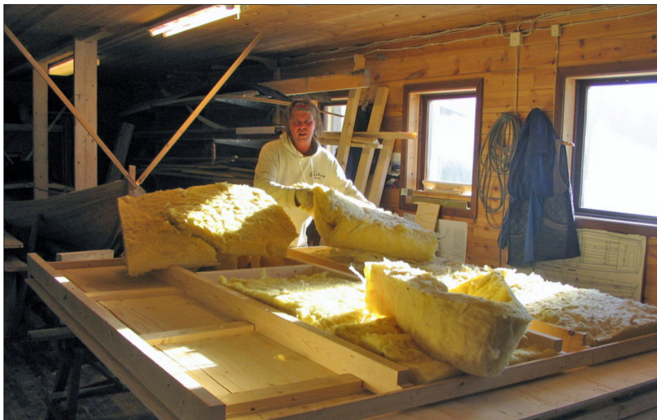
Johnny Lundberg isolerar vägg-element till bastun på Germandön. Foto: Ove Skoog.
