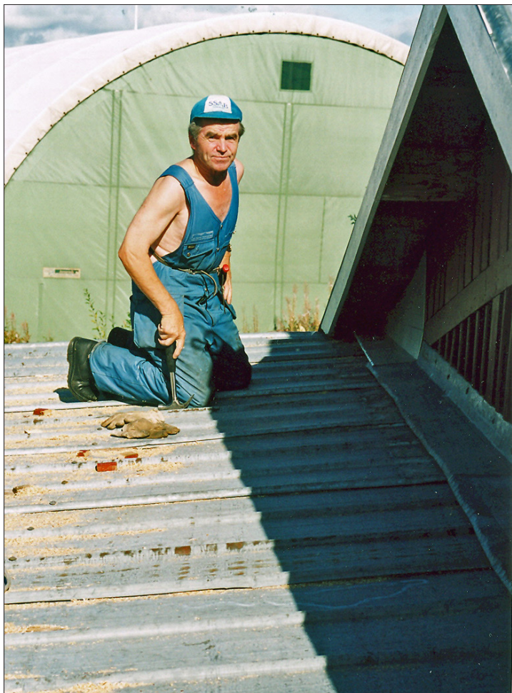
Under våren börjar ett fikarum och ett verktygsförråd med toalett att byggas till på ena gaveln av båtverkstan. Sven Eliasson lägger tak. Foto: Börje Nilsson.
